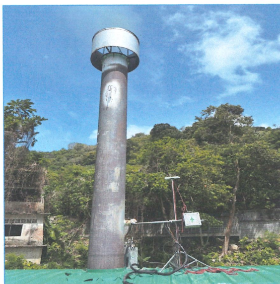
รูปภาพ : Incinerator Model ACI 120 Series 4 โรงแรมกะตะธานี ภูเก็ต บีช รีสอร์ท พารามิเตอร์ : Total Suspended Particulate, Sulfur Dioxide, Oxide of Nitrogen as Nitrogen Dioxide, Carbon Monoxide, Lead, Cadmium, Mercury, Hydrogen Chloride, Carbon Dioxide
