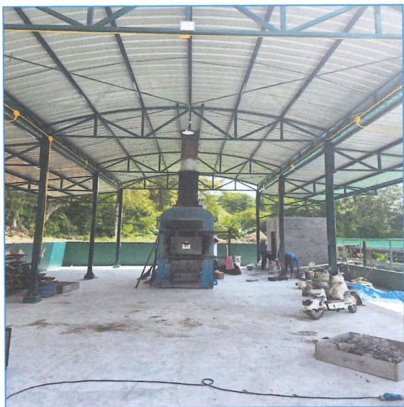
รูปภาพ : Incinerator Model ACI 120 Series 4 โรงแรมกะตะธานี ภูเก็ต บีช รีสอร์ท พารามิเตอร์ : Total Suspended Particulate, Sulfur Dioxide, Oxide of Nitrogen as Nitrogen Dioxide, Carbon Monoxide, Lead, Cadmium, Mercury, Hydrogen Chloride, Carbon Dioxide
